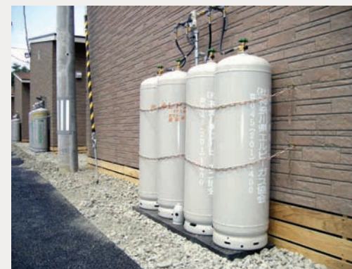
仮設住宅への設置
