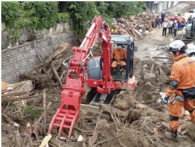
平成26年8月豪雨による広島市土砂災害での小型水陸両用バギー、重機の活用状況 (平成26年8月23日・広島市) (岡山市消防局提供)
