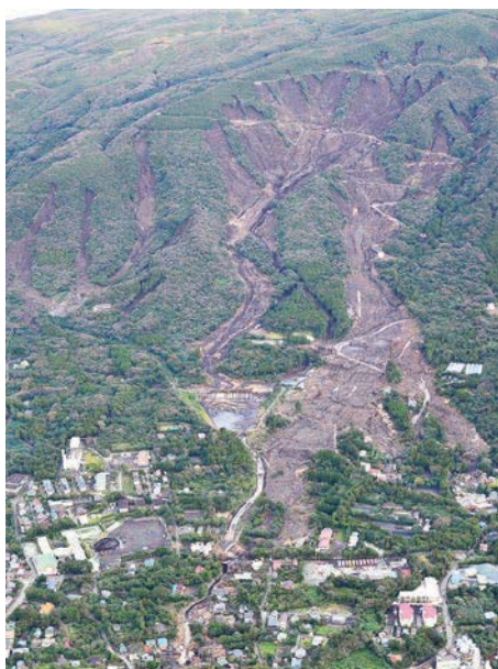
伊豆大島上空からの被害状況
